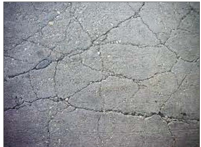
Рис. 1. Тріщини на поверхні асфальтобетонного дорожнього покриття
